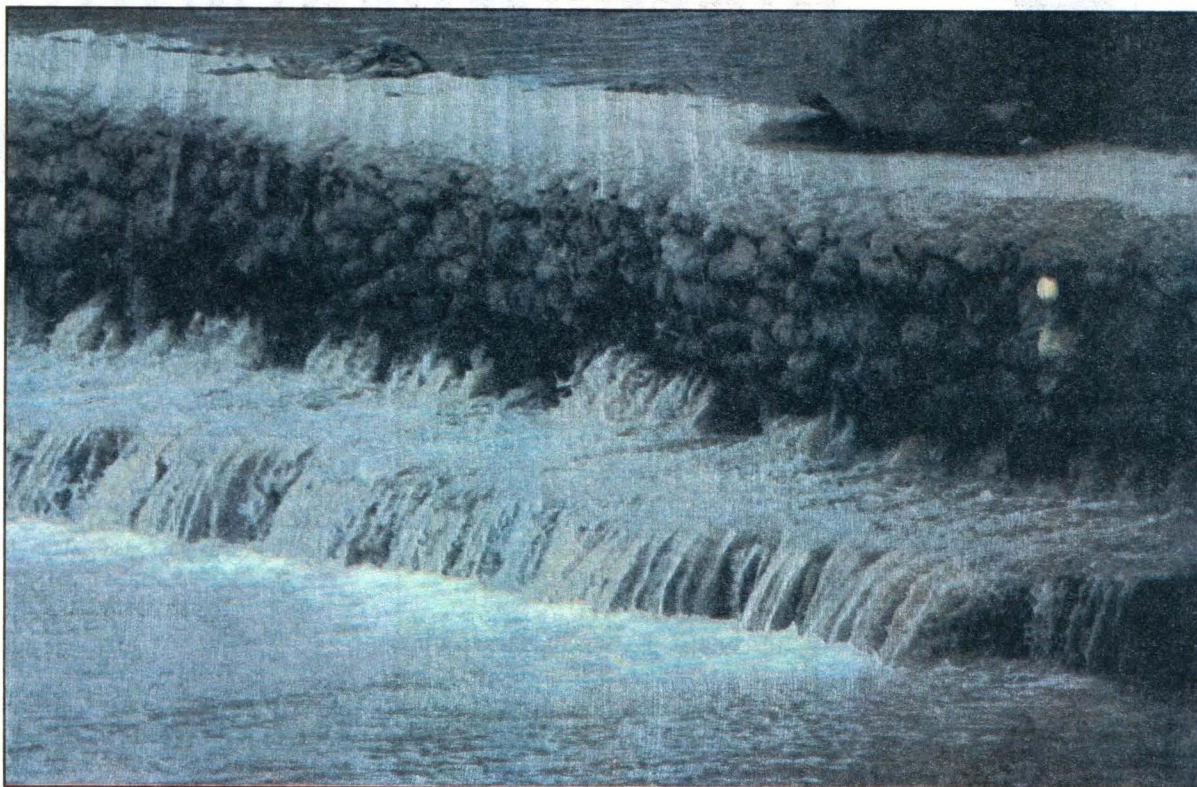
شکل شماره ۶- یکی از موانع دشوار در مسیر مهاجرت مارماهی مرتفع گرفتن پایه پلها و سنگ‌چینی حفاظتی آن است. این کار به منظور جلوگیری از اثرات منفی شن‌برداری صورت می‌گیرد.
